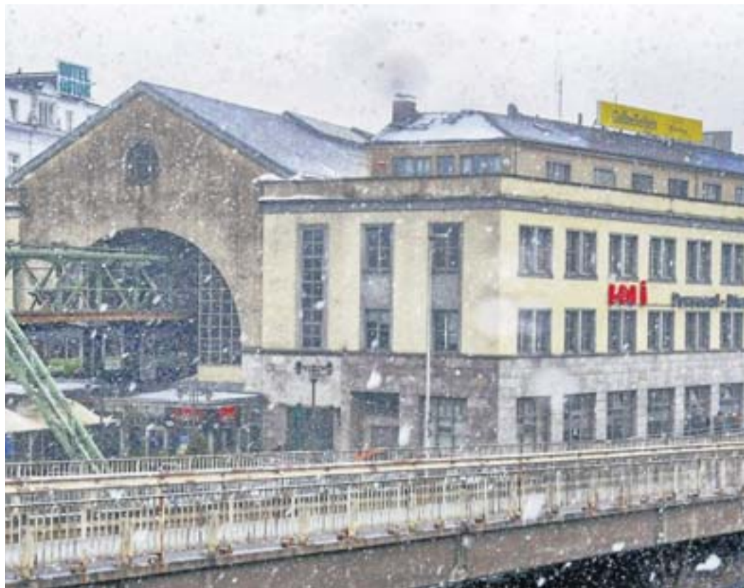
Das Köbo-Haus soll an die neue Bebauung des Döppersberg angeglichen werden.
