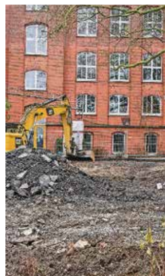
An der Angelo-Roncalli-Schule wird bereits gearbeitet. Foto: Andreas Fischer
