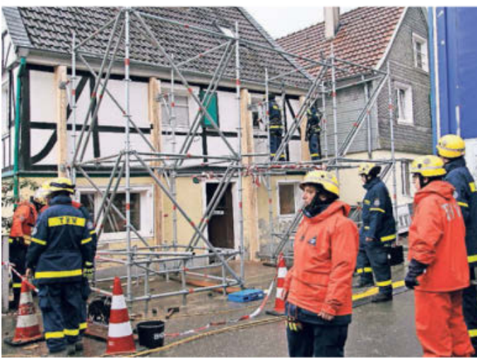
Ein Gerüst wurde im Boden vor dem Haus verankert, Metallstreben stützen es im Innern.
