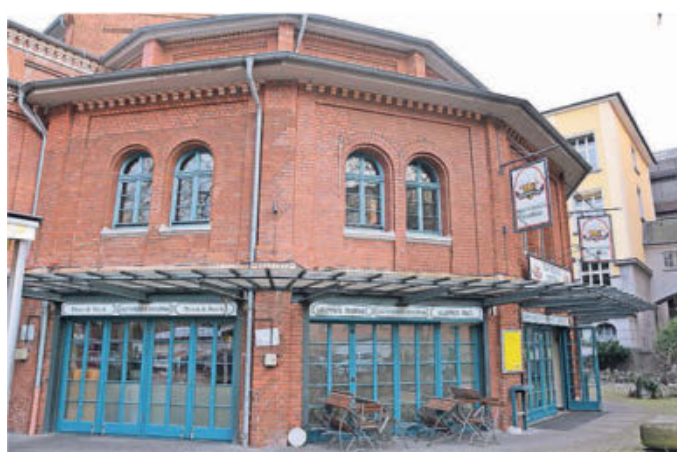
Das Grundstück ist gut 2800 Quadratmeter groß, die Nutzfläche 2400. 800 Gäste haben im Innern Platz.
